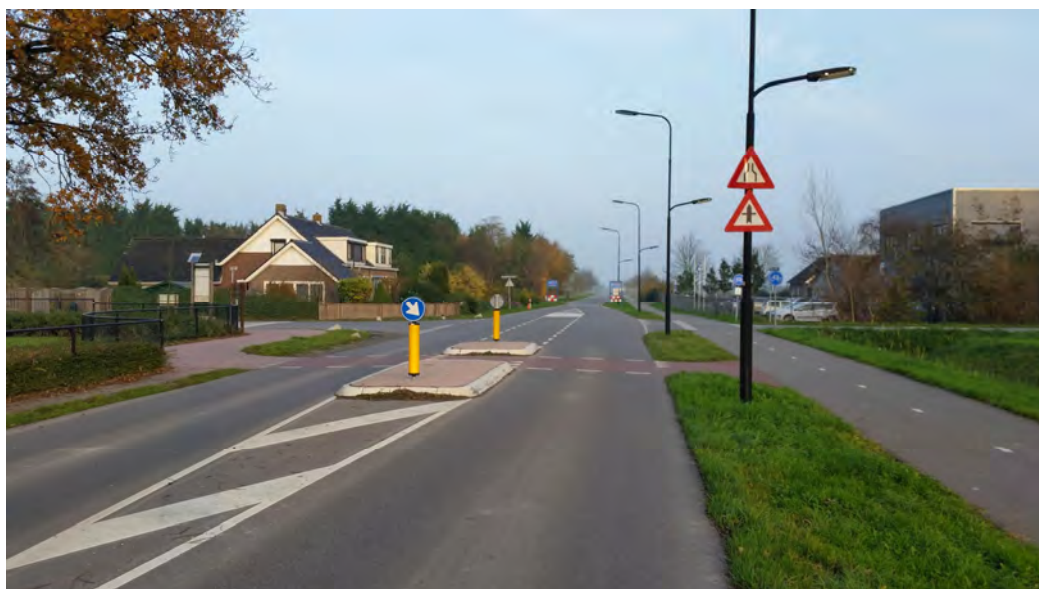
Overzicht onderzoekslocatie vanaf vml. spoorwegovergang richting het oosten
