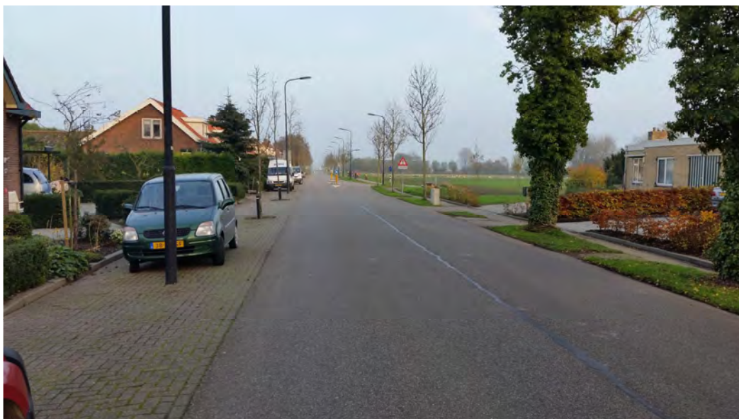
Overzicht onderzoekslocatie vanaf huisnummer 15 richting het oosten
