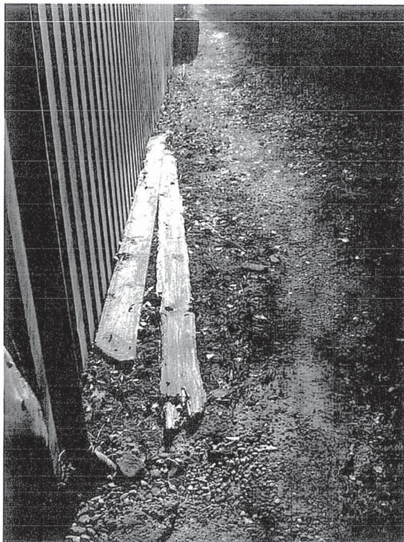
Globale ligging voormalige bovengrondse dieselolietank
