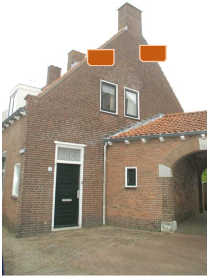
Nr. 2: aan de kopgevel (zuidwest) 2 gierzwaluwkasten. Mogelijk dat hier gierzwaluwen onder de dakpannen aanwezig zijn.
