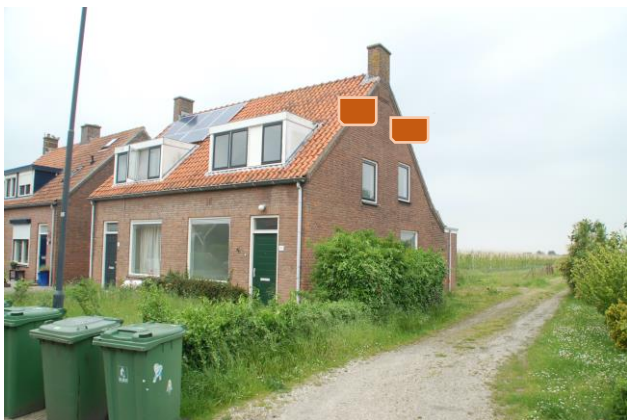
Nr. 11 aan de kopgevel (noord): 2 gierzwaluwkasten;
