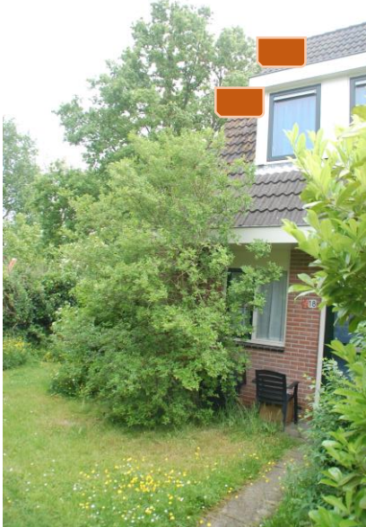
Nr. 18 aan kopgevel (noord) 2 gierzwaluwkasten;
