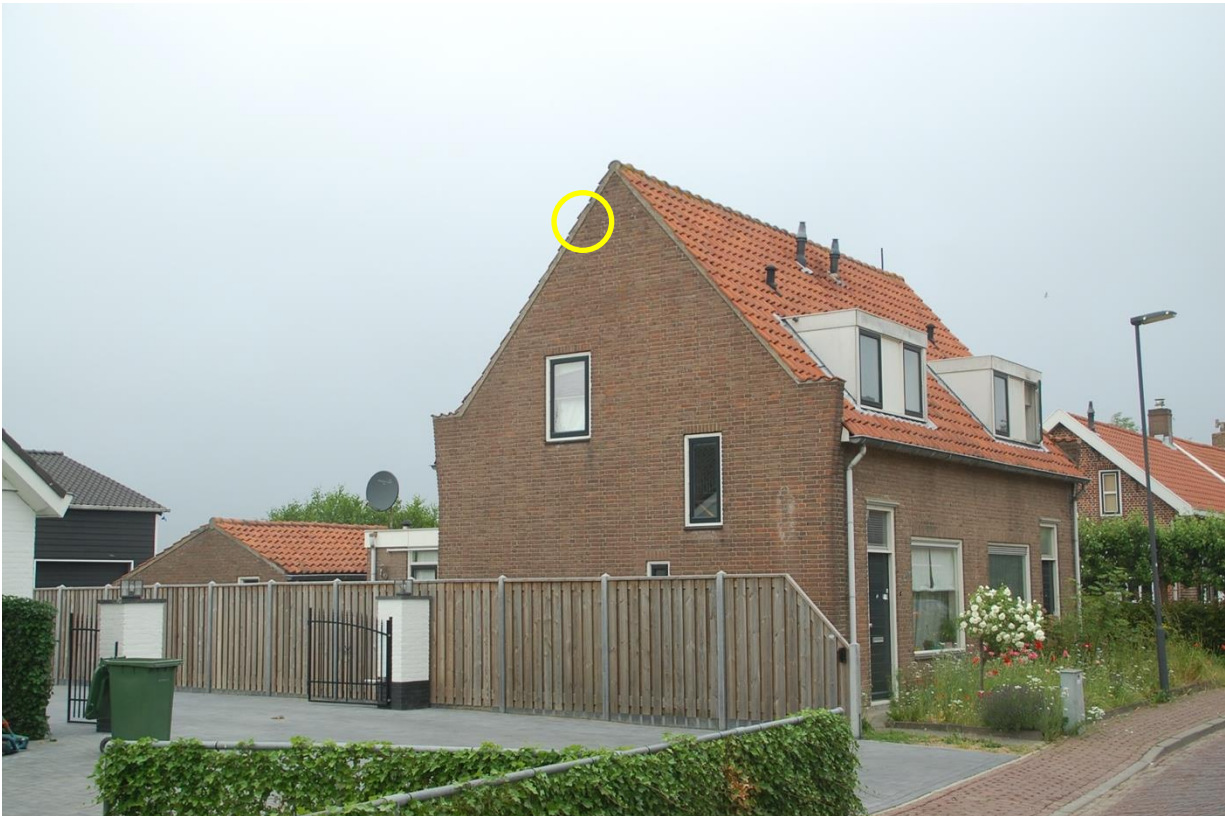
Figuur 7: Onder een van de (losse) kantpannen was een vleermuisverblijf.
