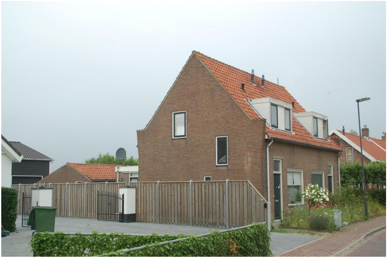
Figuur 3: De te slopen woning.
