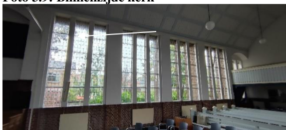
Foto 3.11: Binnenzijde ramen zijgevel kerk
