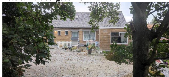
Foto 3.16: Achtergevel Havenweg 6A t/m 6B
