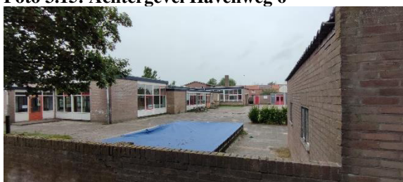
Foto 3.17: Achterzijde bestaande basisschool
