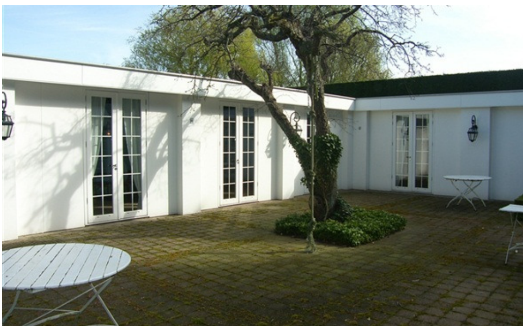
Overzicht teveel gebouwde gebouwen achterzijde onderzoekslocatie
