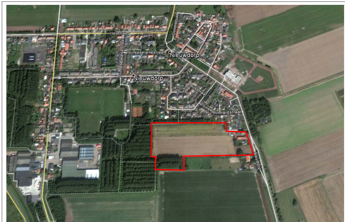
Figuur 3: Luchtfoto bestaande situatie
