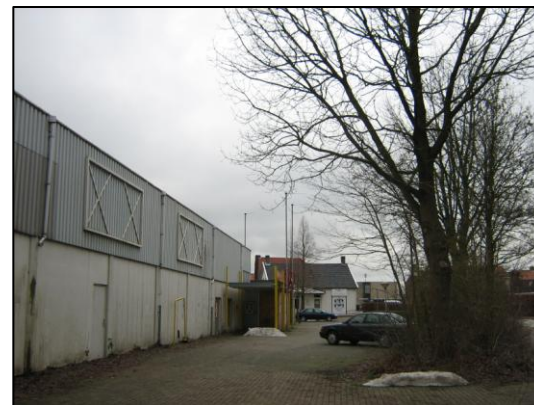
Zuidgevel vml. supermarkt parallel aan Eendvogelstraat
