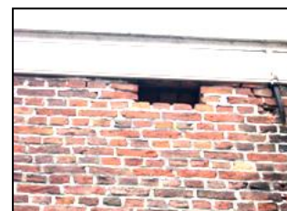
Eén van de drie (tocht-) openingen in de zijgevel Dorpsstraat 84a
