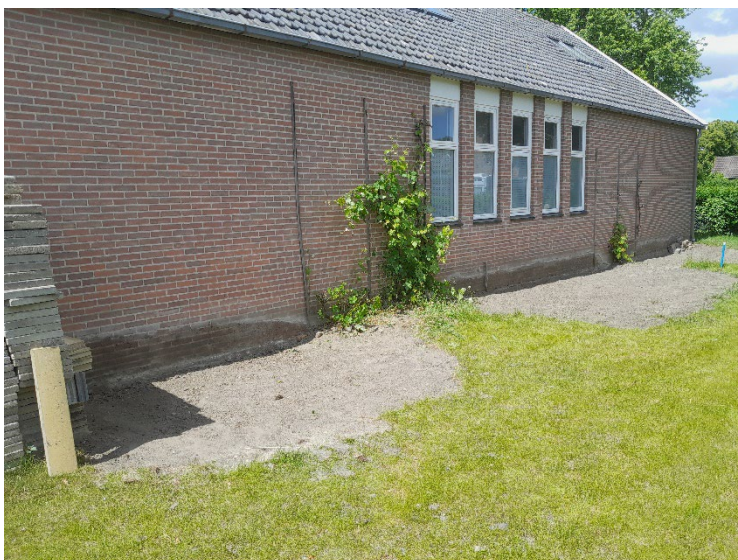
Foto 4 Situatie na afvoer verontreinigde grond (mei 2022)
