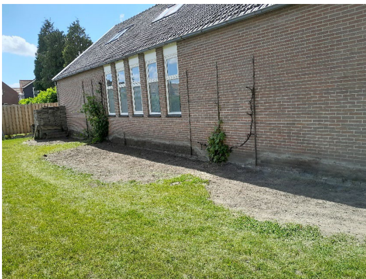
Foto 3 Situatie na afvoer verontreinigde grond (mei 2022)
