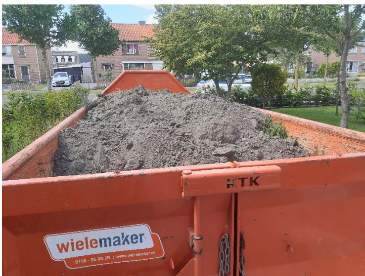
Foto 5 Afgevoerde container (mei 2022)
