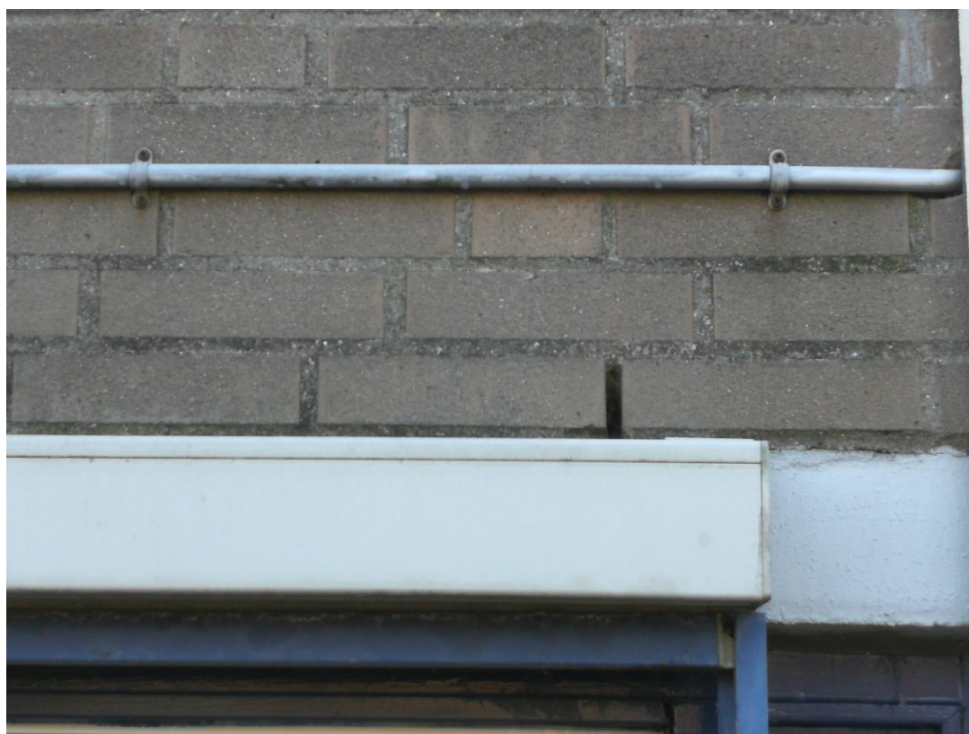
Figuur 3 Open stootvoeg in politiebureau.
