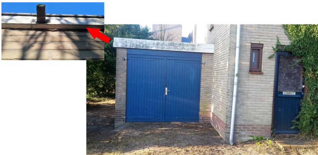
Figuur 4.5.5. Onder de gevelplaat van de garage is plastic aangebracht, zodat hieronder hier geen vleermuisverblijven aanwezig zijn.
