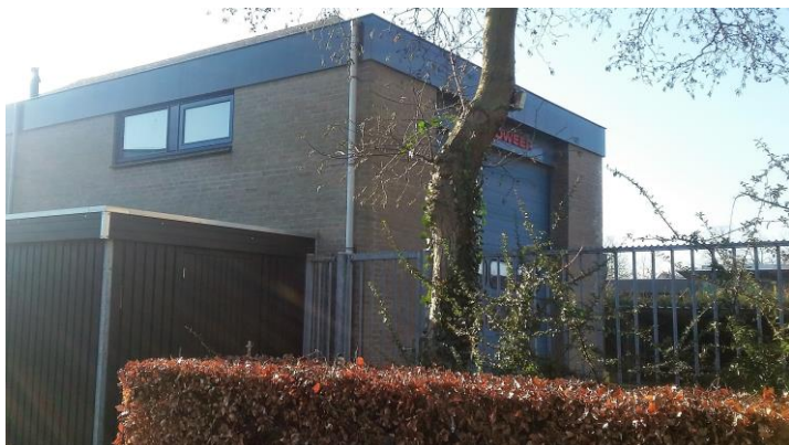
Figuur 4.5.2. Fietsenstalling met plat dak naast het brandweerkazernegebouw.
