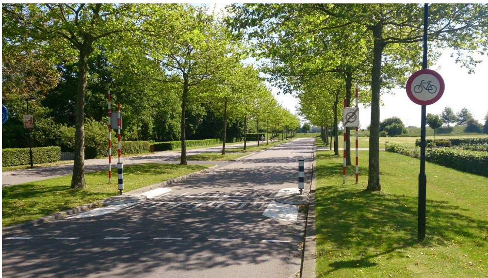
Overgang van 30 km/u naar 50 km/u op de Stenevate
