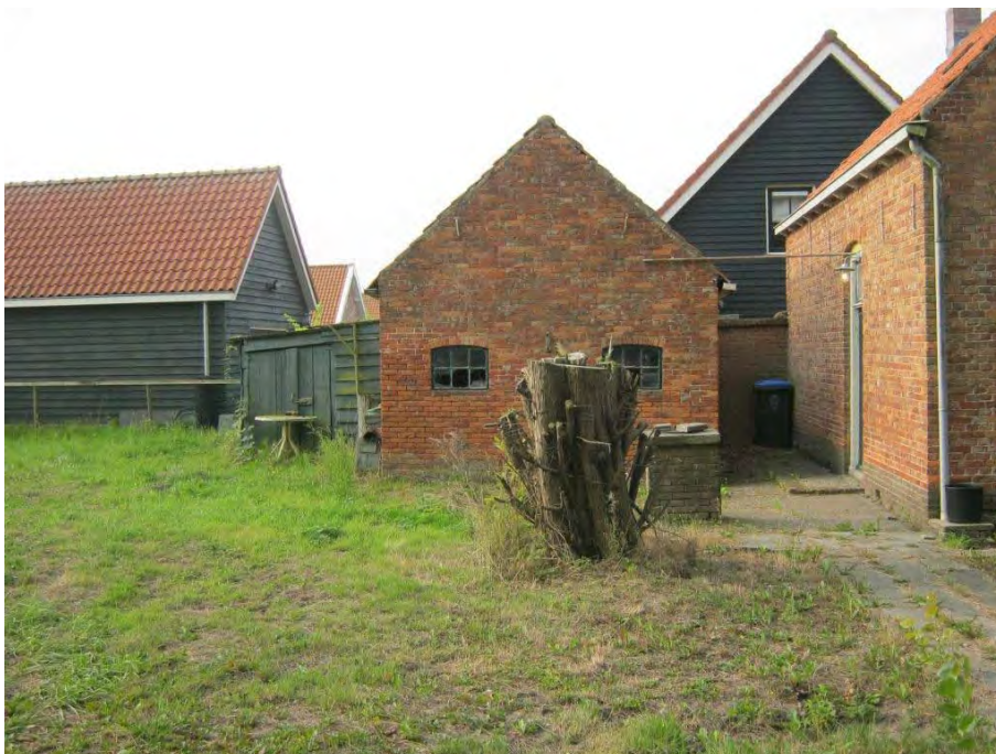
IMG_1839, Geïnspecteerd deel naast houten schuurtje met verouderd dak van asbestverdacht plaatmateriaal.
