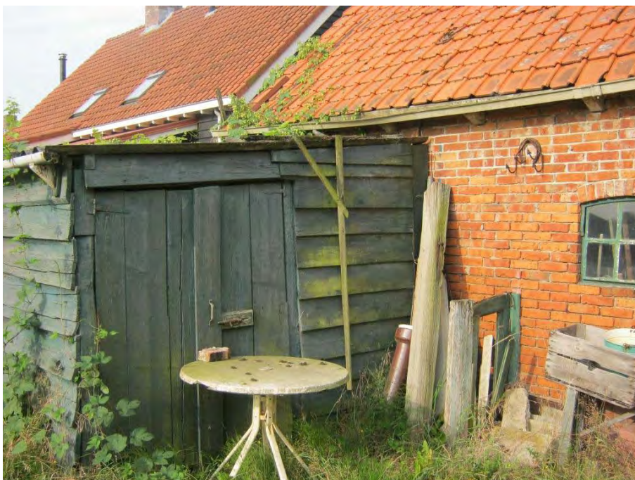
IMG_1001, Schuur met aangrenzend het schuurtje met asbestverdacht plaatmateriaal als dakbedekking gezien in zuidwestelijke richting. Op de achtergrond is de woning te zien aan het Eigen Erf 6a.
