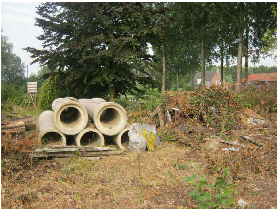
IMG_0988, Asbestverdacht plaatmateriaal en stukjes asbestverdacht materiaal in plastic zakken voor de vijf rioolbuizen gezien in noordwestelijke richting. Voor uitvoering van het veldwerk is het asbestverdachte materiaal afgevoerd naar een milieustraat.
