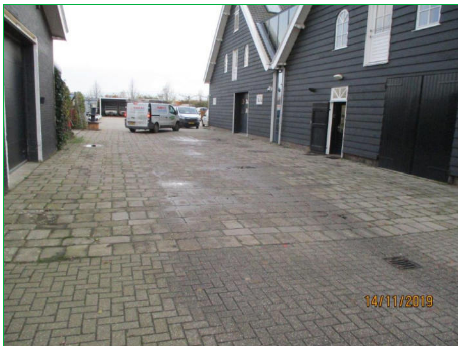
Foto 2 Geplande locatie uitbreiding schuur gezien in zuidelijke richting
