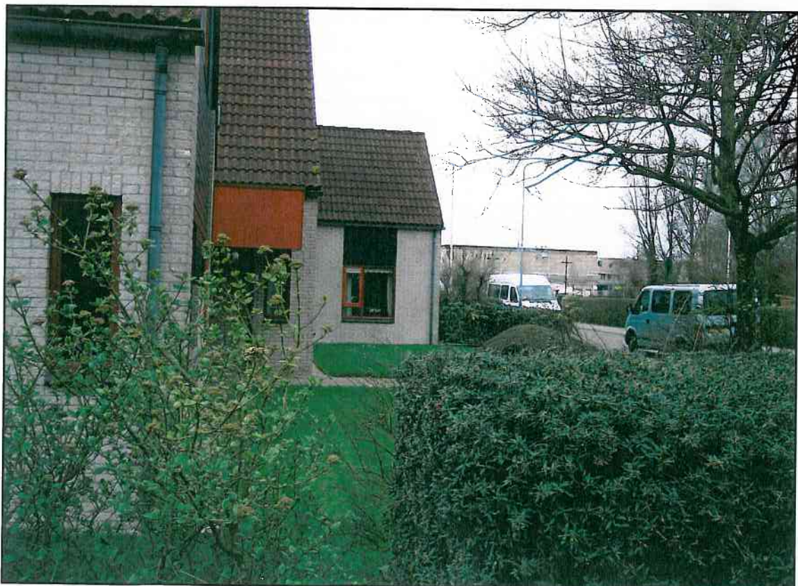
Foto 4: Gezicht op inrichting rondom de Beukelaar in de noordoosthoek van het complex. Kijkrichting westelijk.
