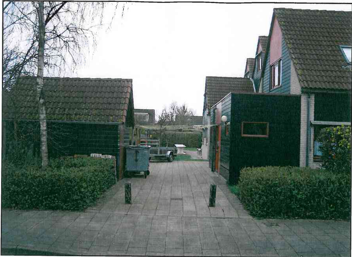
Foto 3: Gezicht op het achterterrein van de Beukelaar. Links op de voorgrond het houten schuurtje uit 1987. Kijkrichting is westelijk.
