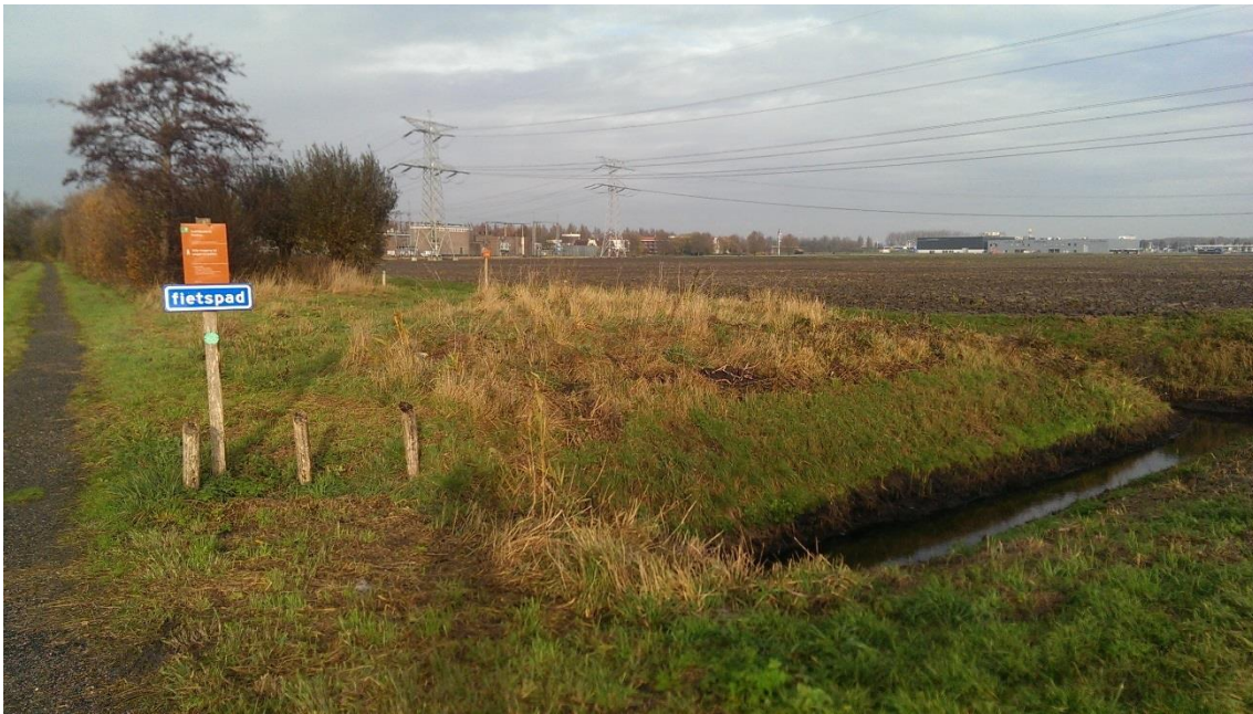
Figuur 5.4 Hoogspanningsstation (achtergrond) met recreatieve ontsluiting Poelbos
