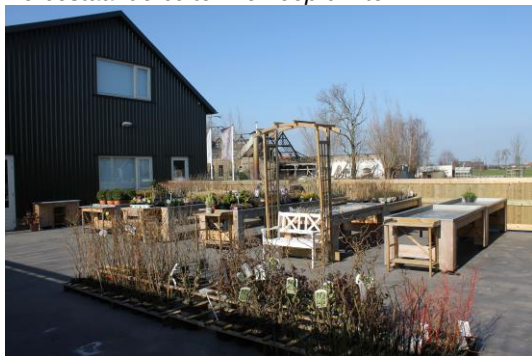
De bestaande buiten verkoopruimte.
