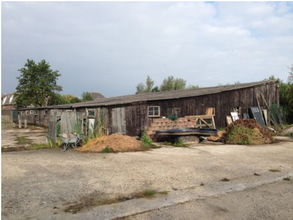
Figuur 3 Achteraanzicht van de te slopen voormalige varkensschuur. Tevens is de terreinverharding goed zichtbaar en het gebruik van het terrein als opslag.
