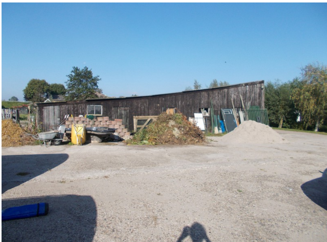
Figuur 4: De te vervangen schuur in het westen van het plangebied
