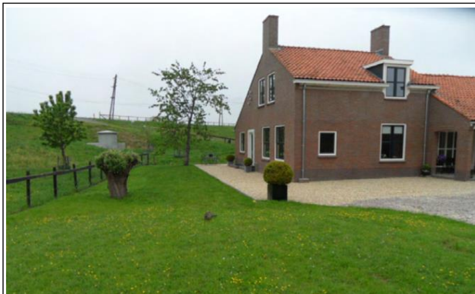
Figuur: Staat van bebouwing (Bron: Verstoep Bouwkundigen)
