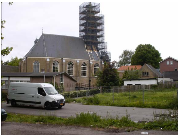
Foto 2: Plangebied gezien in zuidelijke richting
