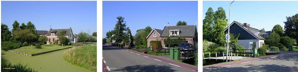
Foto 1. Vrijstaande bebouwing langs de Lageweg
