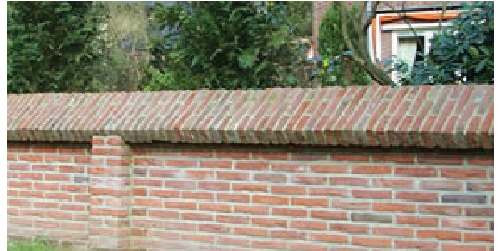
Figuur 34: stenen omhulsel van de betonnen waterkering met de daarbij horende ezelsbrug.
