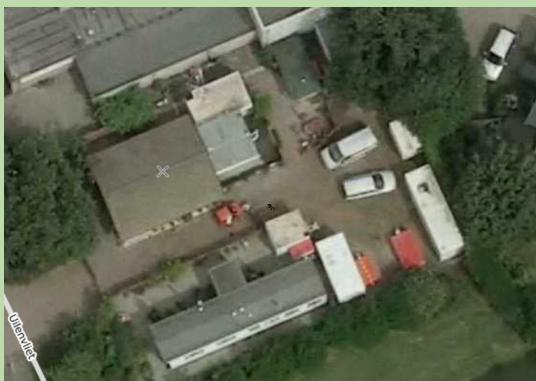
Figuur 2.1 Luchtfoto oude situatie uitbreidingslocatie.
