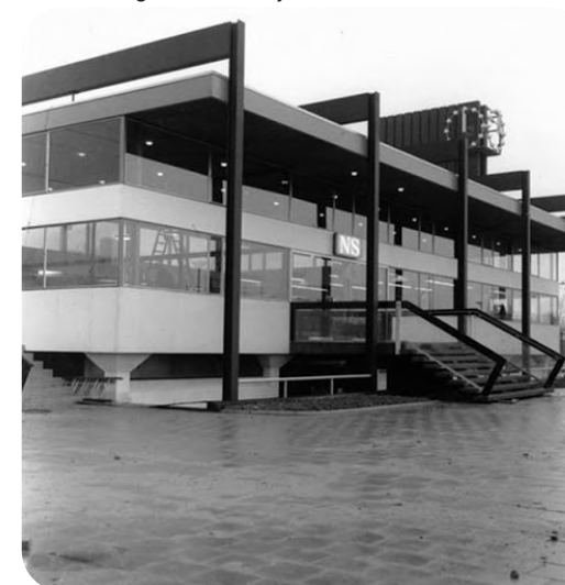
het huidige Station Zwijndrecht in aanbouw 1965
