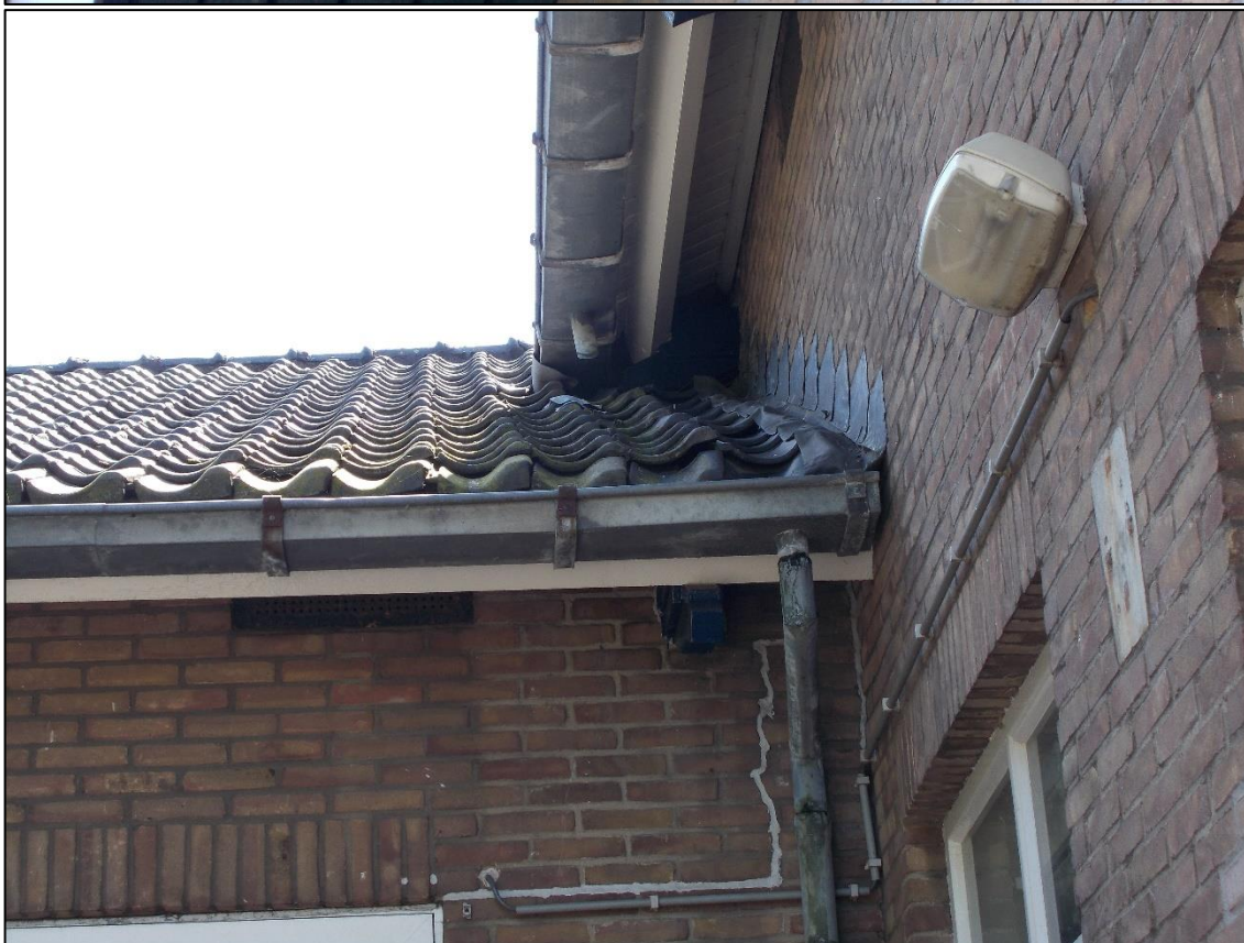
Foto 3 en 4: Bebouwing geschikt als verblijfplaats voor vleermuizen.
