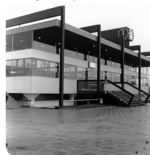
het huidige Station Zwijndrecht in aanbouw 1965
