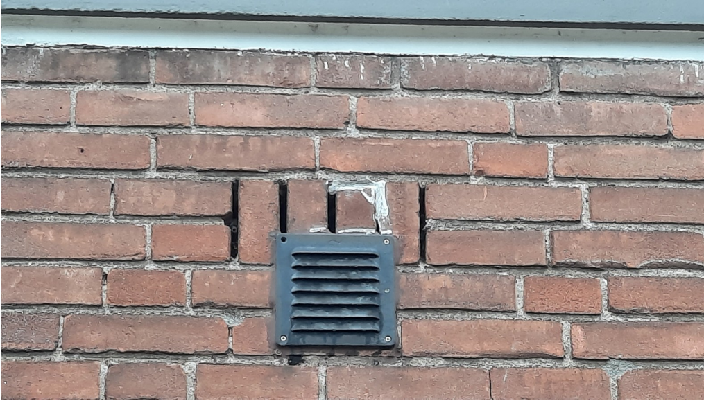
Ventilatievoeg binnen het plangebied. Die vleermuizen toegang geeft tot de luchtpouw. Foto: M.M. Bouwmeester | Ecoresult B.V.
