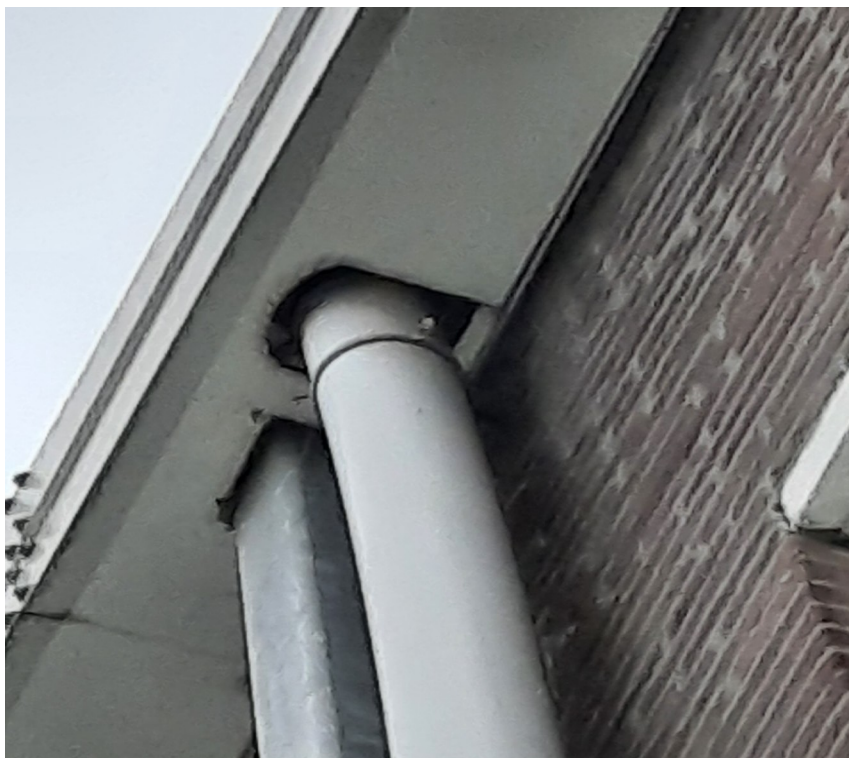
Afbeelding 7: De ruimte rondom de regenpijpen geven huismus en gierzwaluw toegang tot de ruimte in het dakoverstek. Foto: M.M. Bouwmeester | Ecoresult B.V.
