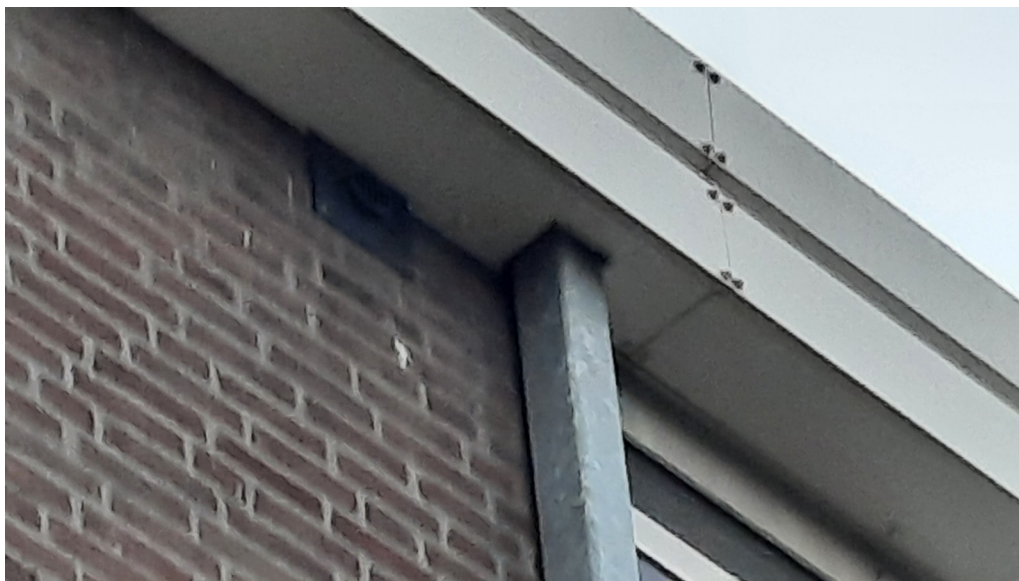
Voor vleermuizen en vogels geschikte ruimte in het dakoverstek en voor vleermuizen geschikte ruimte tussen draagconstructie van het uitpandige balkon en de gevel binnen het plangebied. Foto: M.M. Bouwmeester | Ecoresult B.V.
