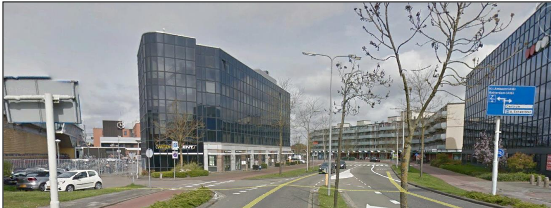
Figuur 2.2a: Overzicht bebouwing noordzijde Stationsweg: zicht vanuit oostelijke richting.
