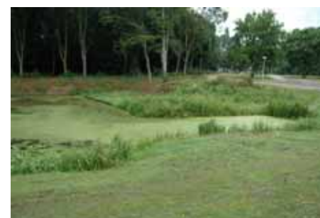
Oostelijke toegangsdam: belijning is verrommeld door grondaanvullingen
