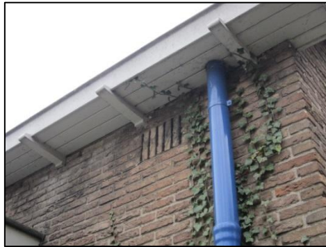
Ventilatiegaten in muur oostelijke zijde
