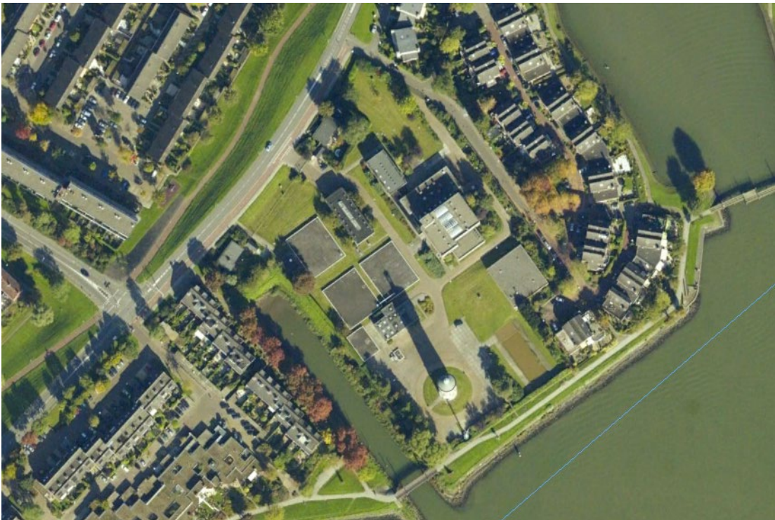
Luchtfoto locatie Watertoren Zwijndrecht
