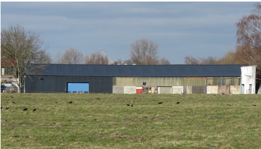
Afbeelding 2: Het grasveld en één van de loodsen in het plangebied.
