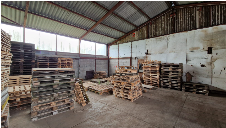
Afbeelding 6: De hoek van de loods waar zich ten tijde van de quickscan een binnenruimte bevond met sporen van steenmarter.
