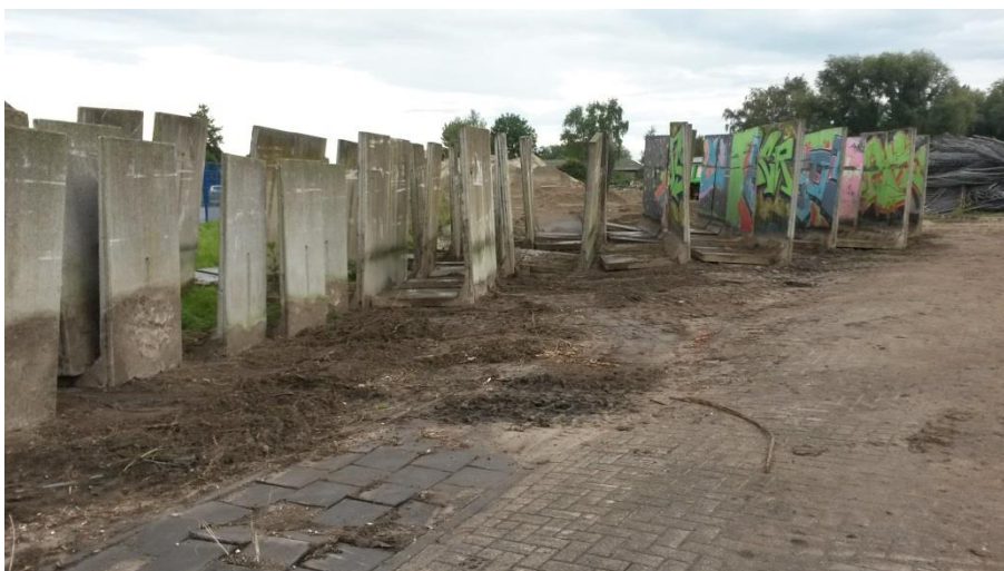
Foto 1: verwijderde keerwanden en hekwerken
