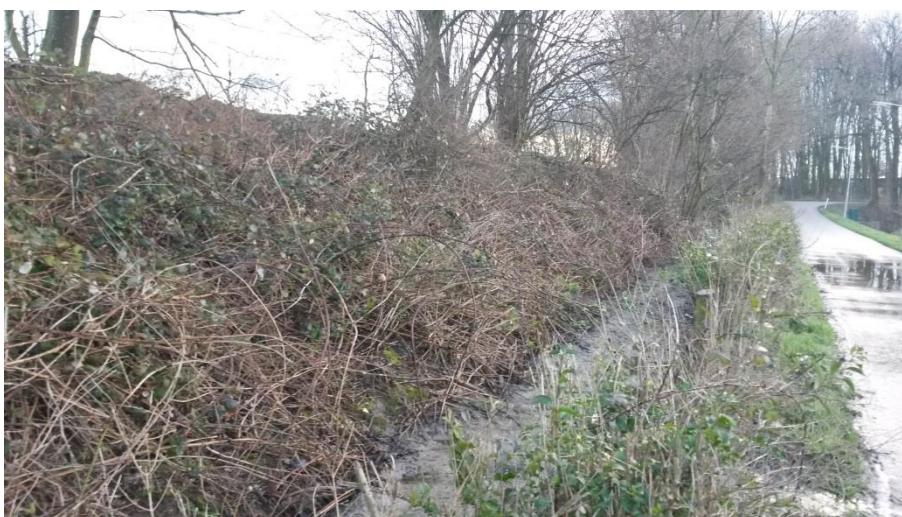
Foto 16: eindsituatie aan zijde talud zuidzijde
