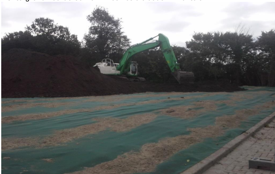
Foto 8: aanbrengen leeflaag op het scheidingsdoek
