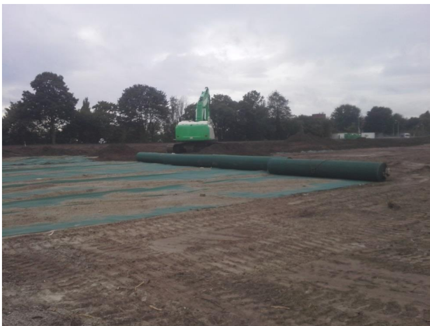
Foto 4: aanbrengen scheidingsdoek
