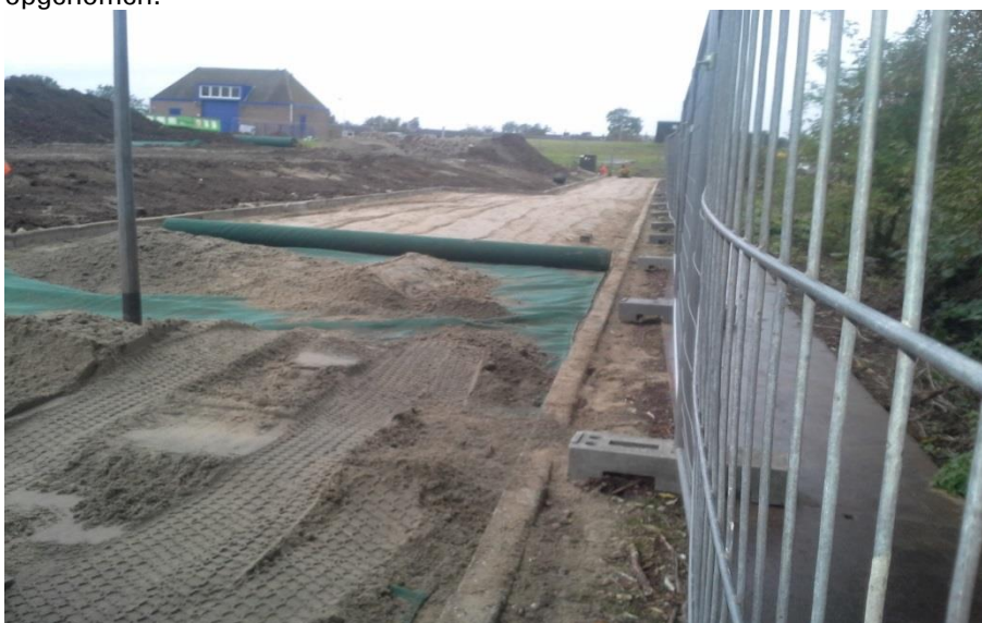
Foto 9: aanleg verharding met signaleringsdoek en schoon zand
