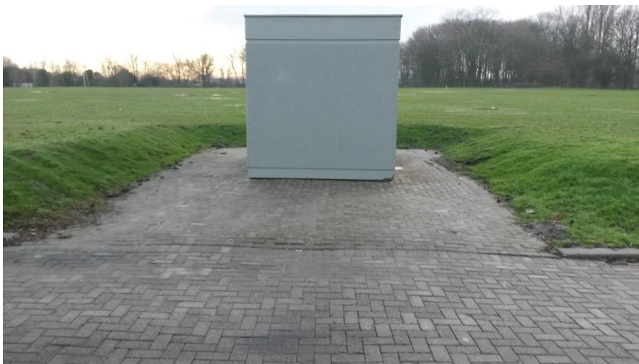
Foto 10: verharding rondom trafogebouw aan zijde Ringdijk
