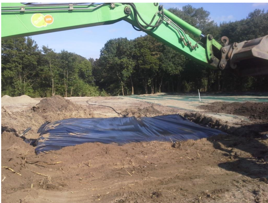
Foto 6: aanleg gasdrainage met HDPE afdekking
