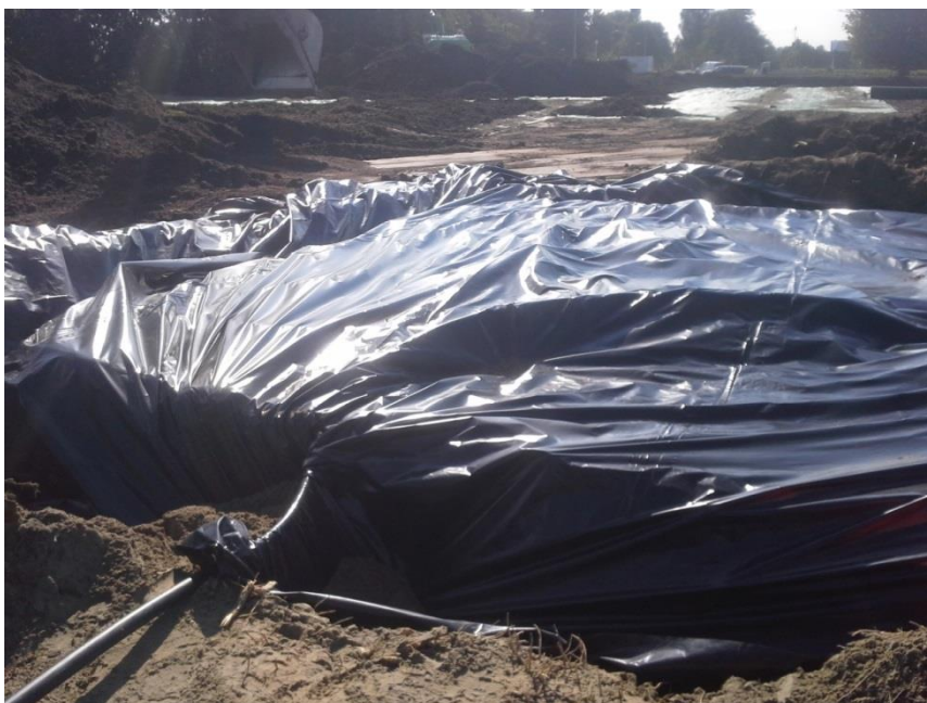
Foto 5: aanleg gasdrainage met HDPE afdekking
