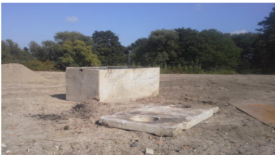
Foto 2: gereinigde en verwijderde olie-waterafscheider
