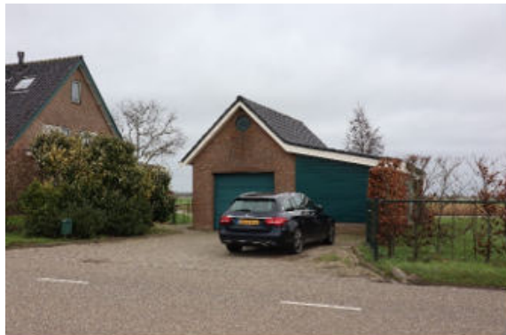
Garage/berging met links de woning.
