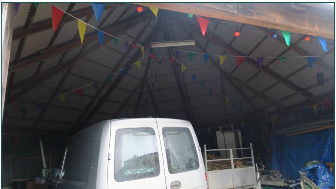
Figuur 4 De hooiberg is opgebouwd uit een spantconstructie en metalen golfplaten als muren en dak.
