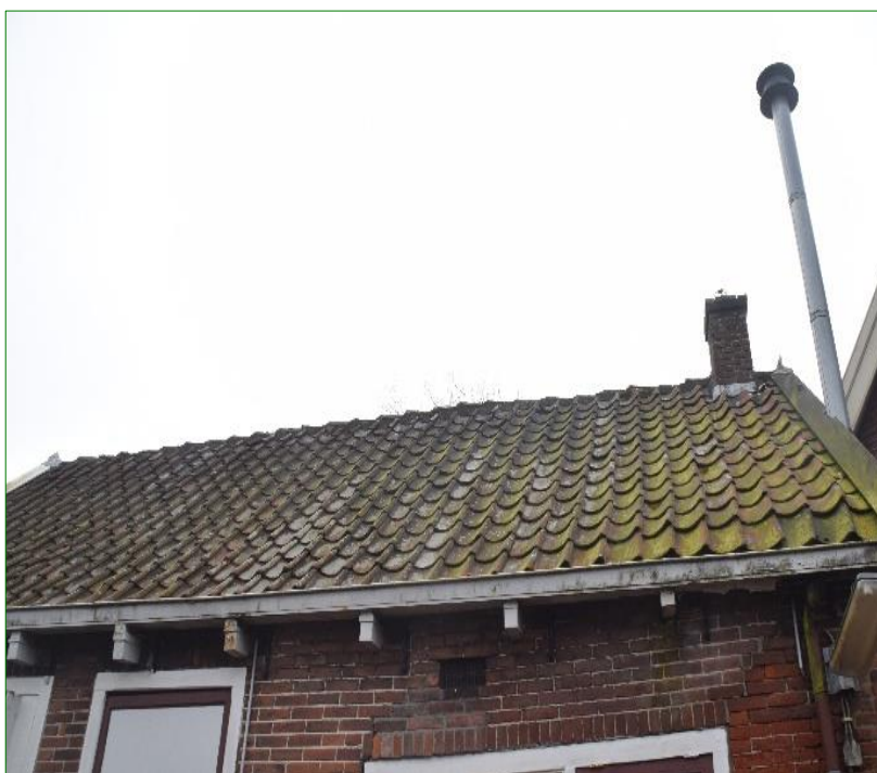
Dak en dakrand van het slachthuis
