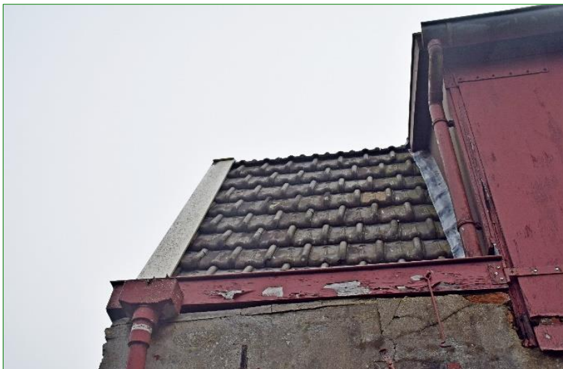
Dak en windveer van de koeienstal
