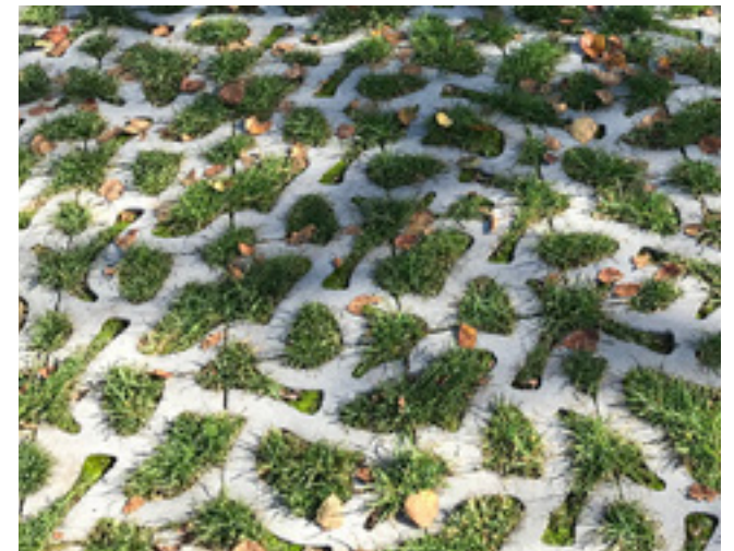
Open verharde parkeerplaatsen Flood Bold, Rain(a)way (o.g.)
