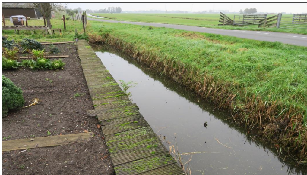
Figuur 4 De watergang welke direct aan de zuidzijde van de planlocatie is gelegen.
