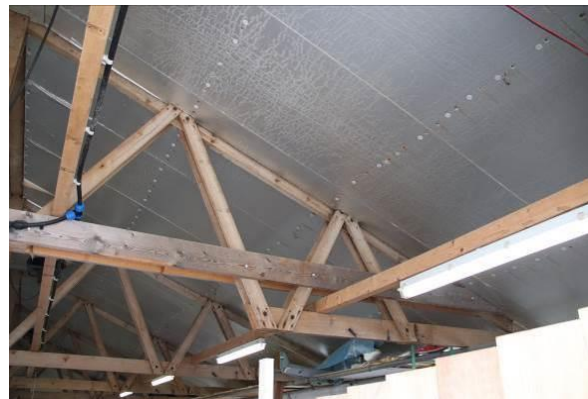
Figuur 5.2 Het dak van de schuur, van binnenuit geïsoleerd.
