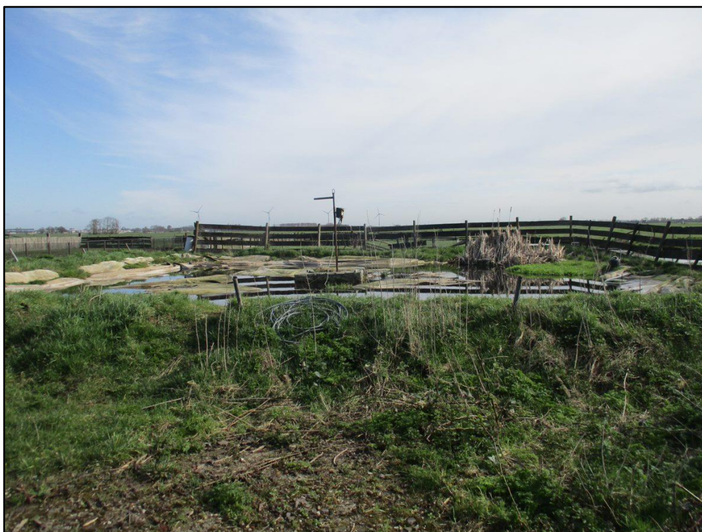
Figuur 4 De fundering van de meststilo.
