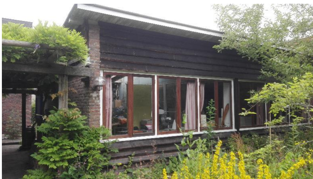
Figuur 2 De werkplaats wat tevens op de planlocatie is gelegen bevat steense muren en houten rabatdelen. Het dak is plat en gemaakt van bitumen.
