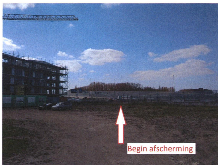
Figuur 5: Afscherming naast appartementen in aanbouw
