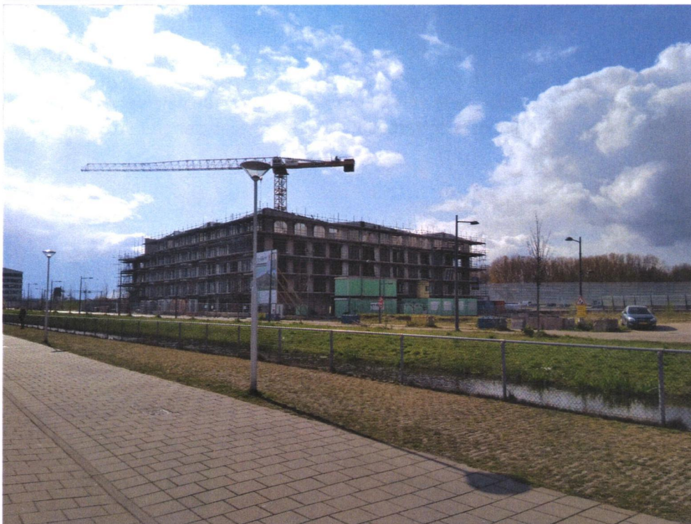
Figuur 1: Woningen in aanbouw april 2019
