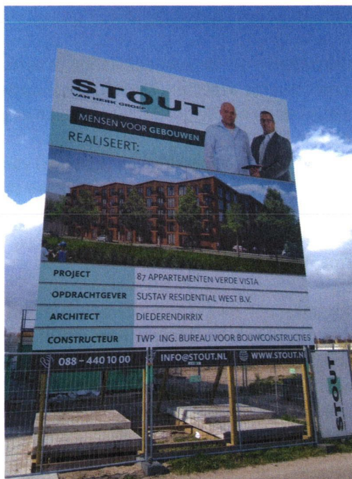
Figuur 2: Woningen in aanbouw april 2019
