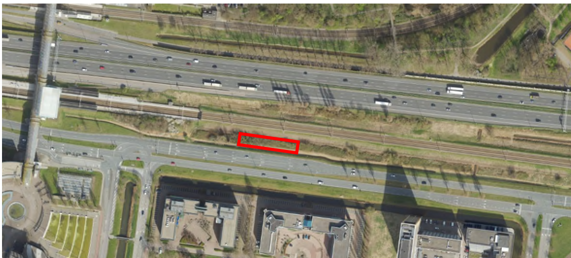
Figuur 2-3: Luchtfoto met arcering projectlocatie
