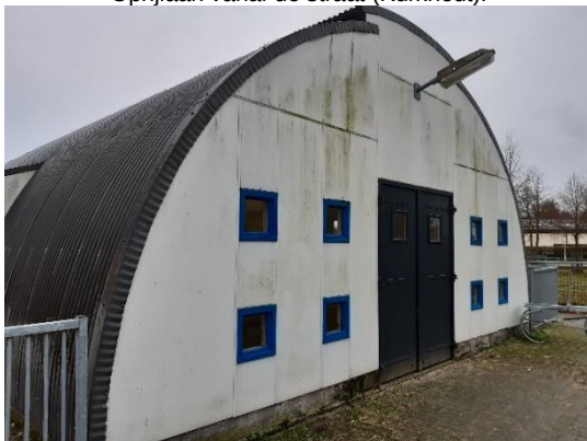
Kopse kant van romneyloods
