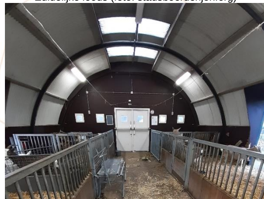
Binnenkant van loods
