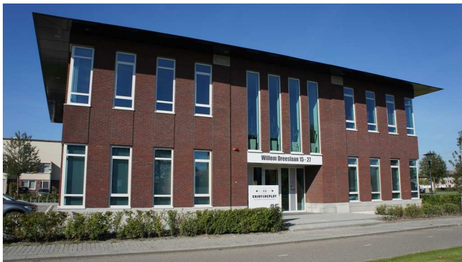
Figuur 4.2 Bestaande situatie voorgevel Willem Dreeslaan 15
