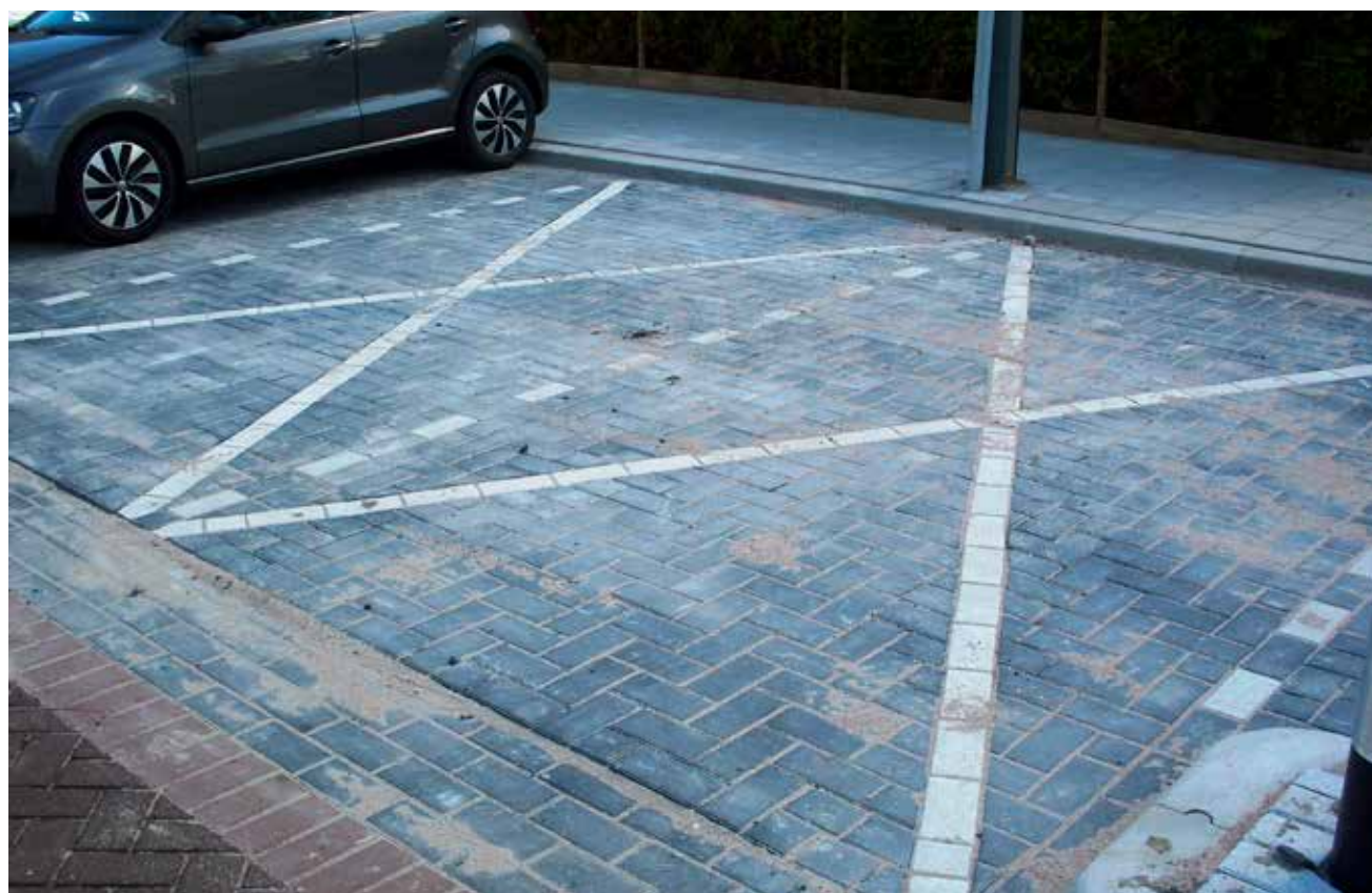
Markering parkeervak elektrische oplaadpunten
