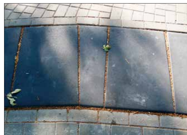
Inritblok 50 x 80 detail zaagstuk in bocht
