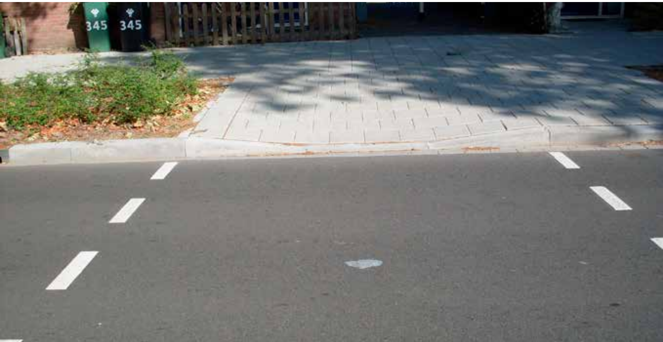
Verlaagde trottoirband met kanalisatiestrepen
