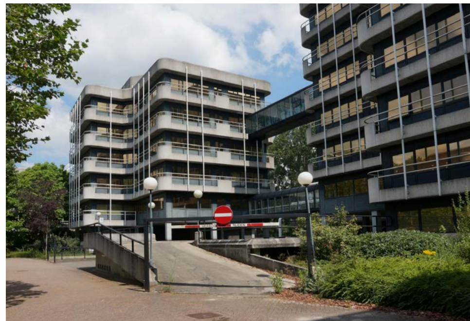
Oprit naar het parkeerdek en lichtbruggen. <Flexus AWC>
