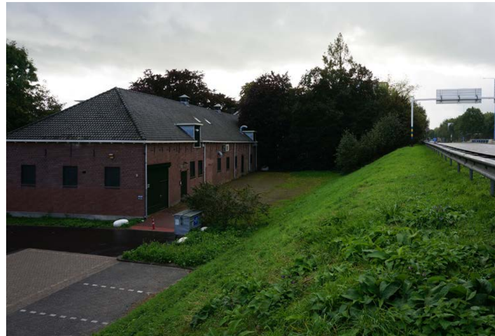
Voorweg 54, boerderij Kahnlust, ligt heel dicht tegen het talud van de Afrikaweg. <FlexusAWC>
