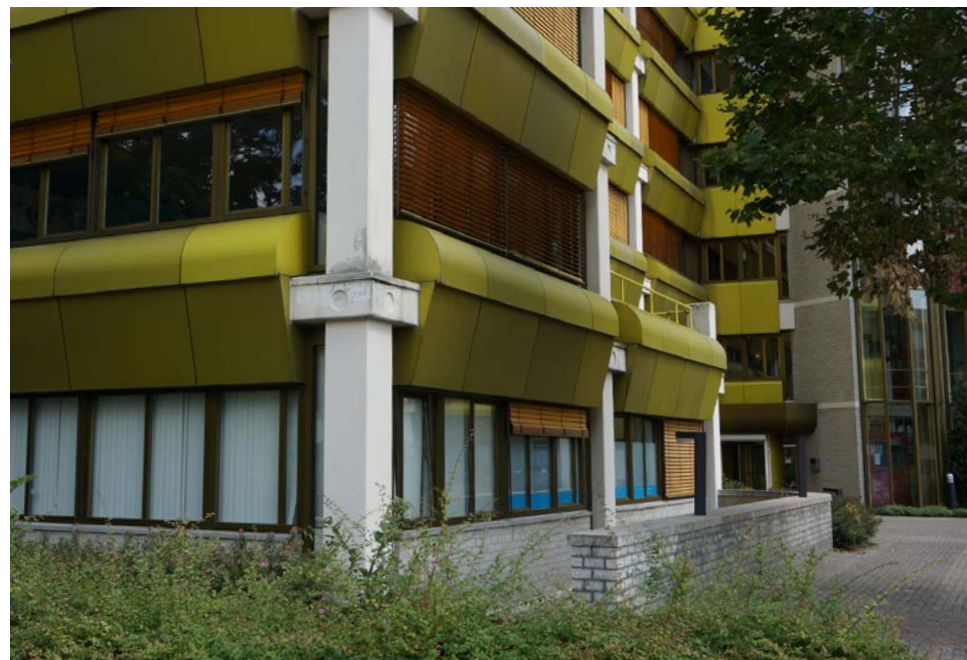
Detail van de gevelopbouw. <Flexus AWC>
