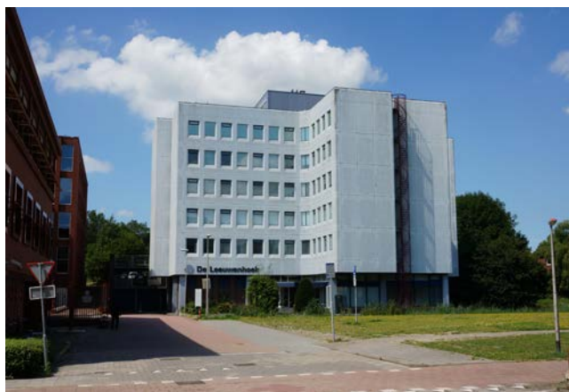
Kantoorgebouw De Leeuwenhoek. <FlexusAWC>
