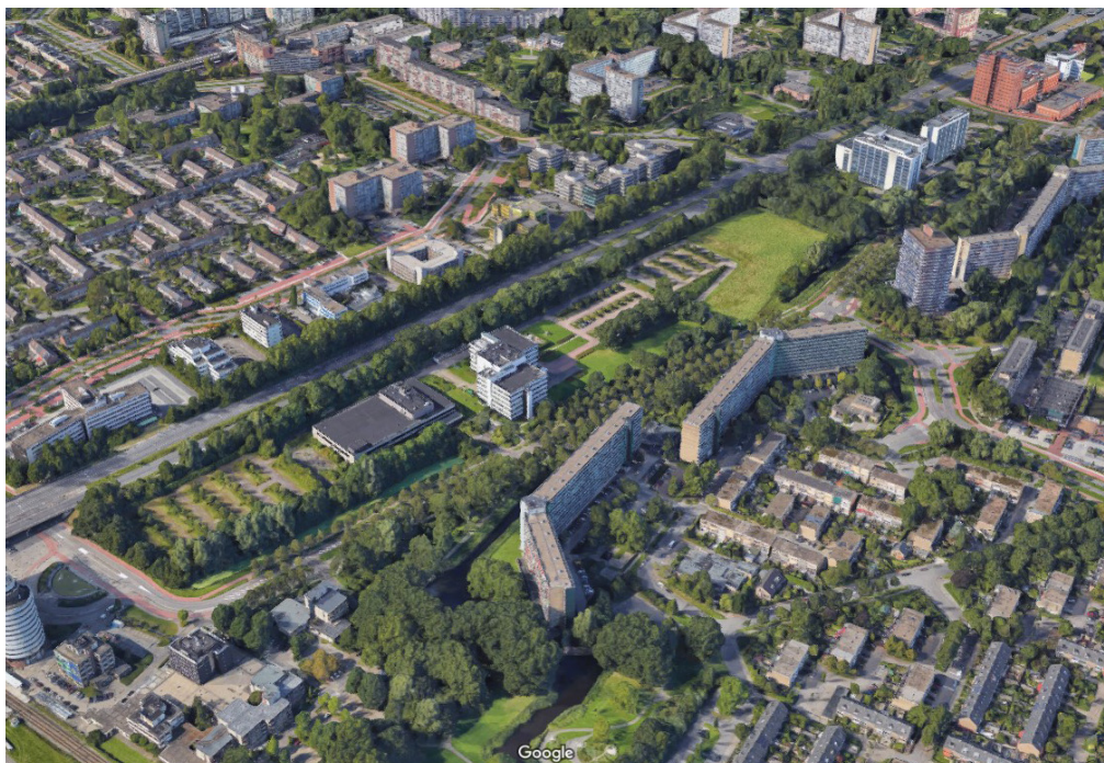
De grootschalige kantorenstrook Afrikaweg-Oost.
