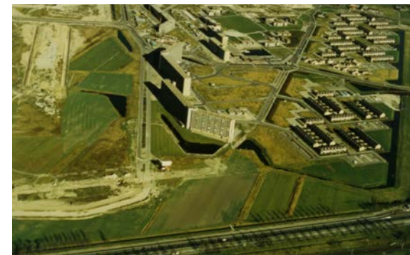
De wijk Driemanspolder en de Afrikaweg in aanbouw. <SAZ>
