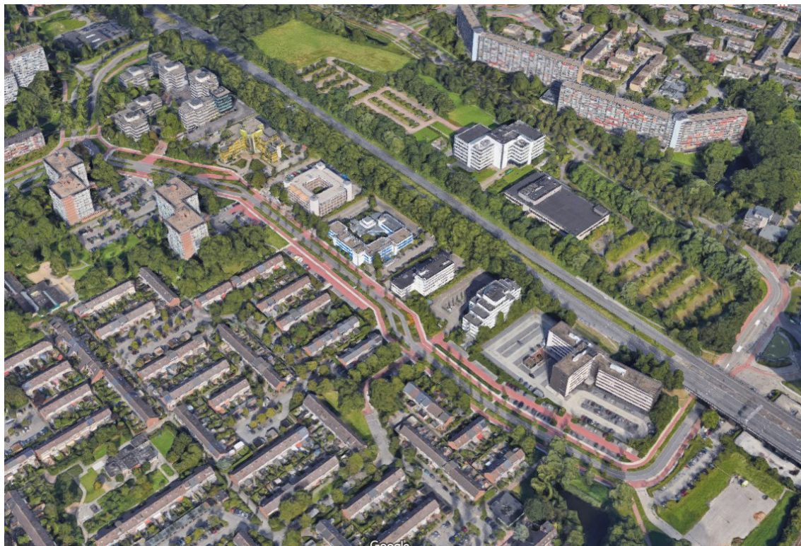
De kleinschalige kantorenstrook Afrikaweg-West.
