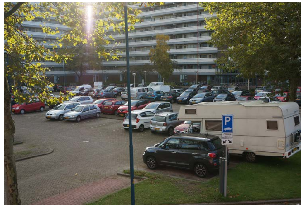
Grote parkeerterreinen voor de flats. <FlexusAWC>
