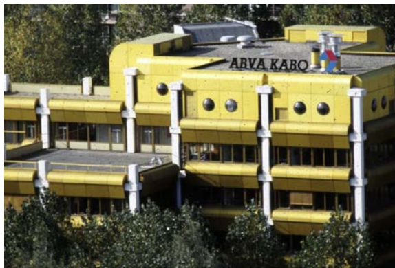
Oostgevel met installatieruimte en ronde vensters, 1980-90. <SAZ>
