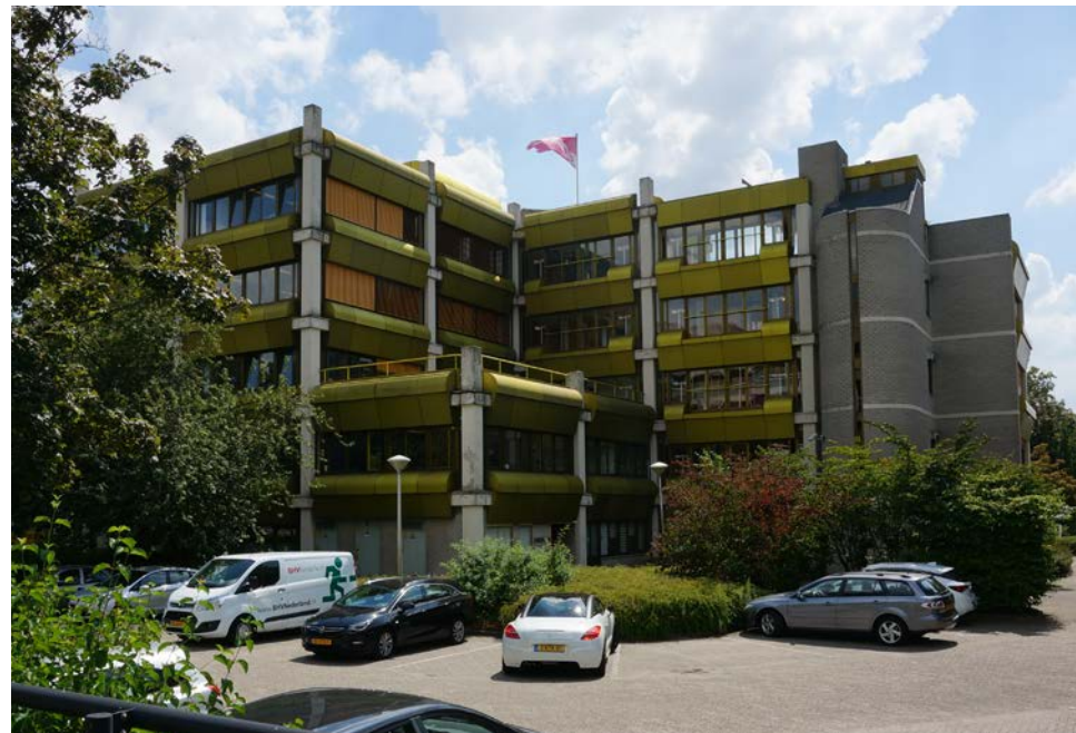
Noordwestgevel. <Flexus AWC>
