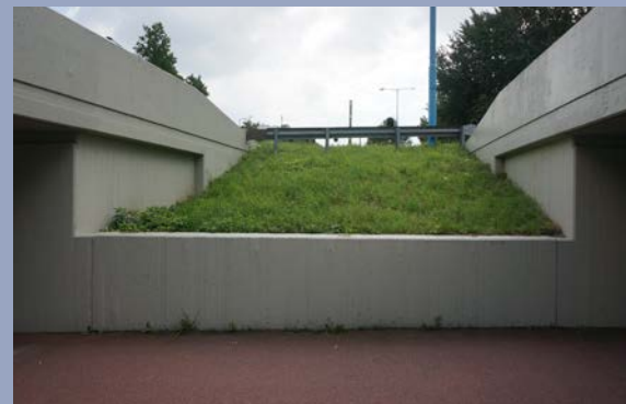
De twee viaducten over het Abdissenpad.
