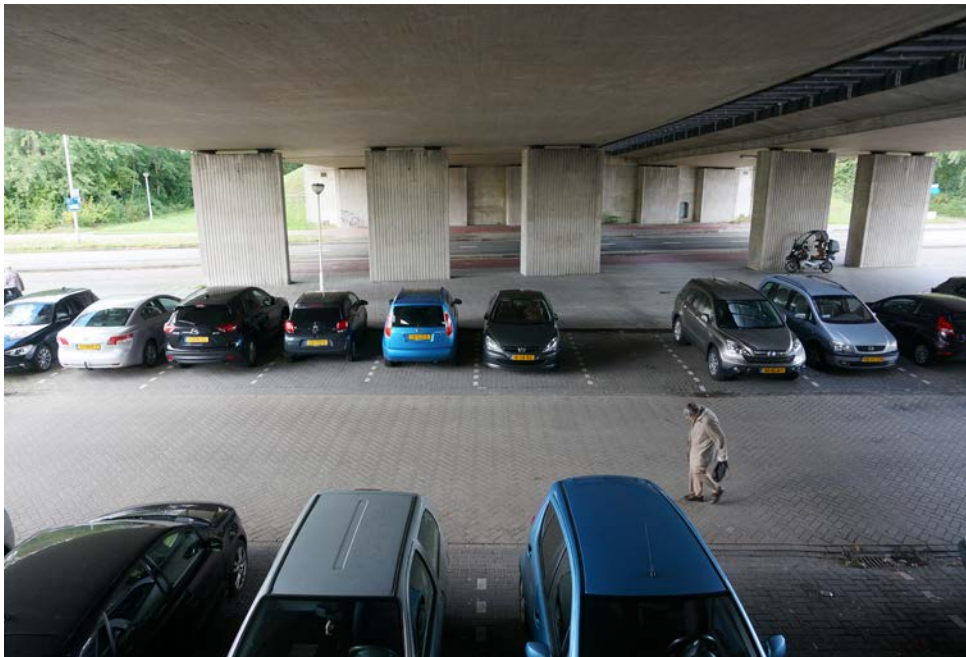
Onder het viaduct van de Afrikaweg. <FlexusAWC>
